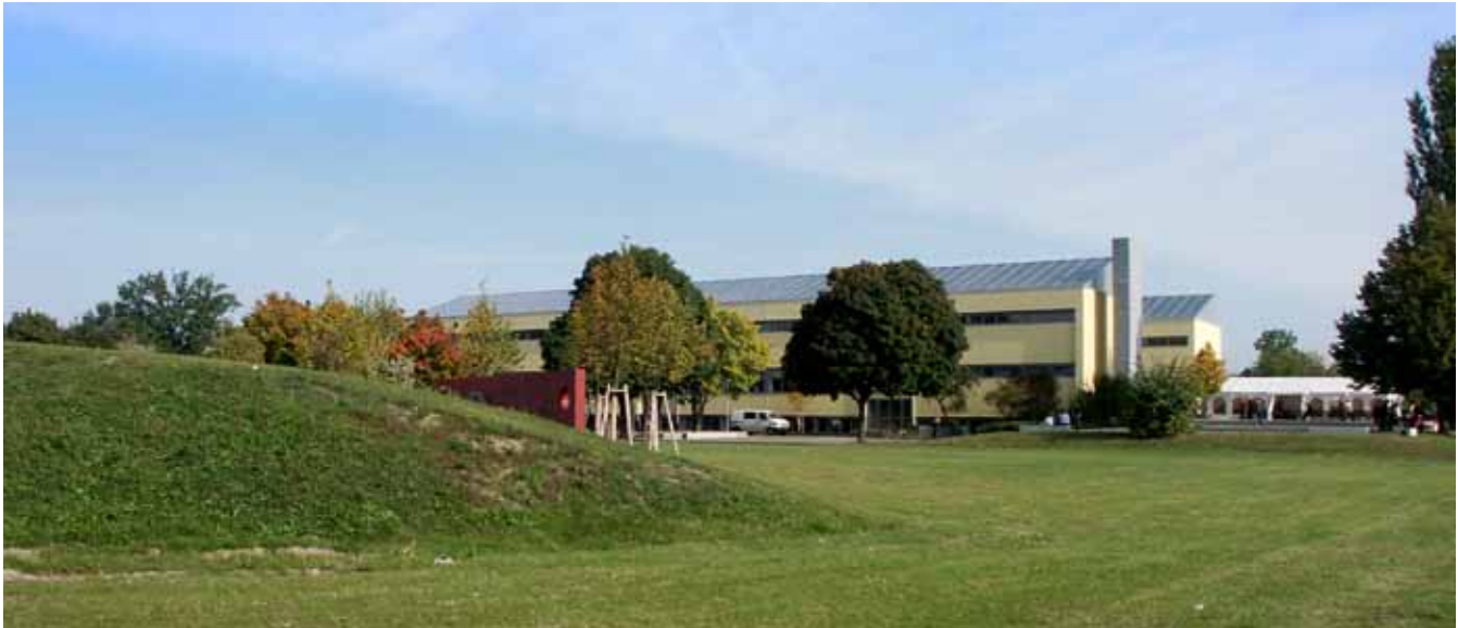
Kies-Wasser-Wärmespeicher (vorne) und Schulgebäude mit 1000 m 2 Kollektorfläche (hinten) in Eggenstein
