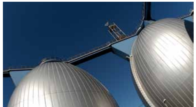
Durch anaerobe Schwarzwasserbehandlung entsteht Biogas
