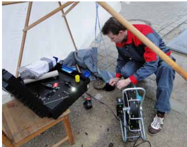
Einbringen einer Kamera in eine Unterdruckleitung
