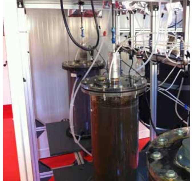
Versuchsstand mit CSTR-Fermentoren zur anaeroben Vorbehandlung von Schwarzwasser
